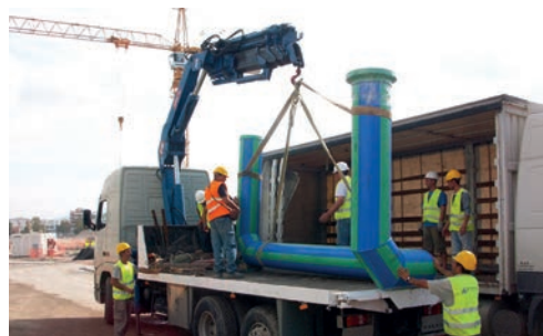
Доставка на стройплощадку
