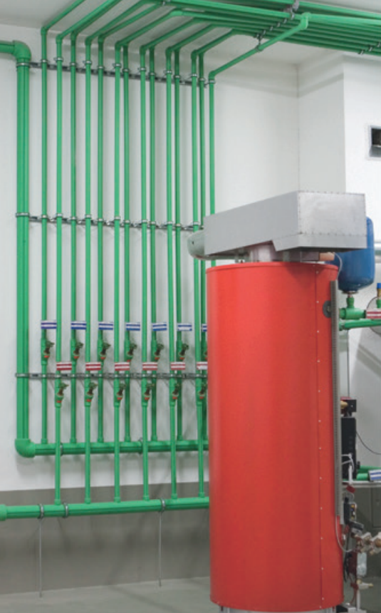
Распределитель для систем водоснабжения и отопления в жилом здании
