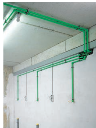
Монтаж на штукатурку
