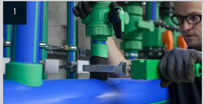
Приварка наварного седла на главную трубу
