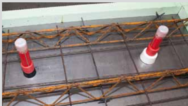
1. Вид подключения - видимый спринклер
